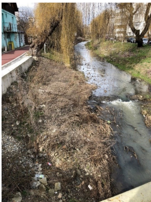
Maluri colmatate și alunecări de taluz
